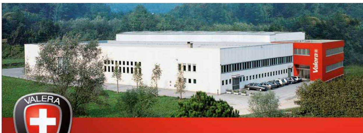
Ligo Electric S.A. Via Ponte Laveggio, 9 CH 6853 Ligornetto/Mendrisio (Switzerland)
